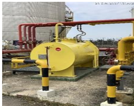
ภาพที่ 8 อุปกรณ์ดับเพลิงภายในคลัง
